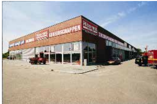
Een simpel bedrijfsgebouw met een overdaad aan illegaal aangebrachte uitingen van reclame die niet aan de criteria voldoen.
