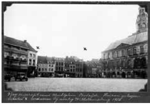
Oude gevel Markt voor doorbraak brug
